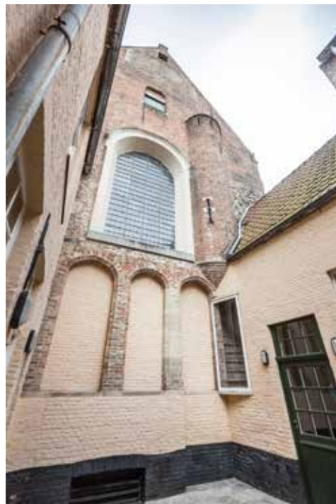
→ De westgevel van 't Keerske, volledig ingebouwd aan een binnenkoertje
