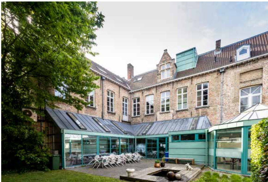
Tuingevel met diverse bouwsporen (Stad Brugge, Matthias Desmet).
