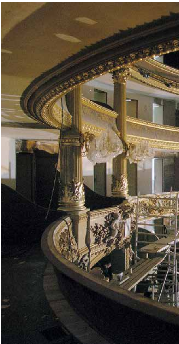
De theaterzaal tijdens de restauratiewerkzaamheden omstreeks 2001-2002 (Stad Brugge, Jan Termont).
