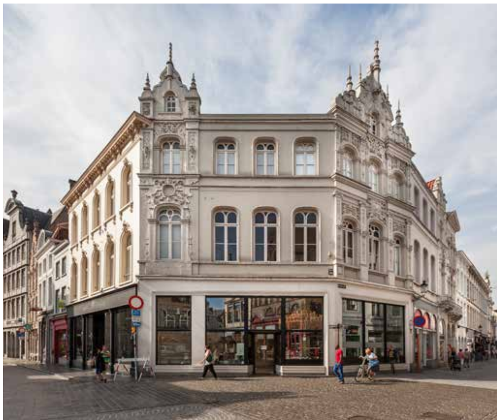
Vanaf 1859 werd de Geldmuntstraat plaatselijk verbreed en vervangen door panden met speelse neoclassicistische lijstgevel -n.o.v. stadsarch. J.B. Rudd. - (© Stad Brugge, Matthias Desmet).
