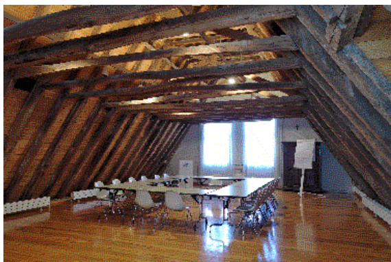
Huis De La Torre - Dit is een van de oudst gekende gebinten in Brugge
