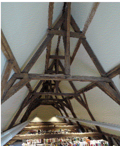
Tolhuis - Dit 15 de -eeuwse gebinte werd hergebruikt na een 17 de -eeuwse verbouwing
