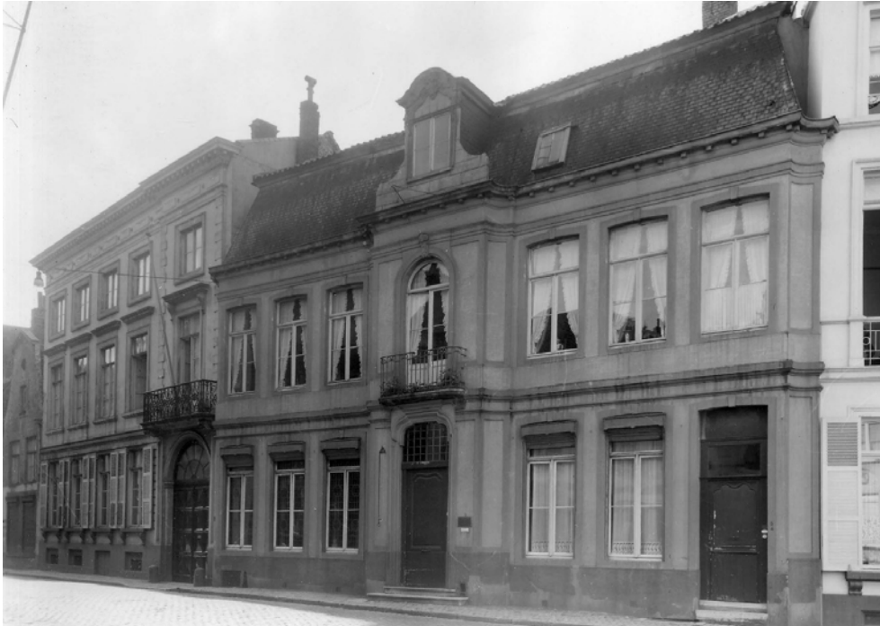
Zwart-witfoto gedateerd anno 1952. Merk de rolluikkasten met rolluiken bij de ramen op de benedenverdieping en het ontbreken van de waaier-bovenlichten in beide deuropeningen. Twee jaar later zou het schrijnwerk opnieuw veranderen waarbij kleinhouten werden aangebracht in de vensterramen. https://balat.kikirpa.be/object/110029
